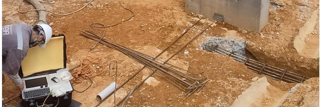
Instalación de los sensores en las columnas de un edificio en construcción en Sabaneta, Antioquia. Foto: cortesía Julián Sierra Pérez.
