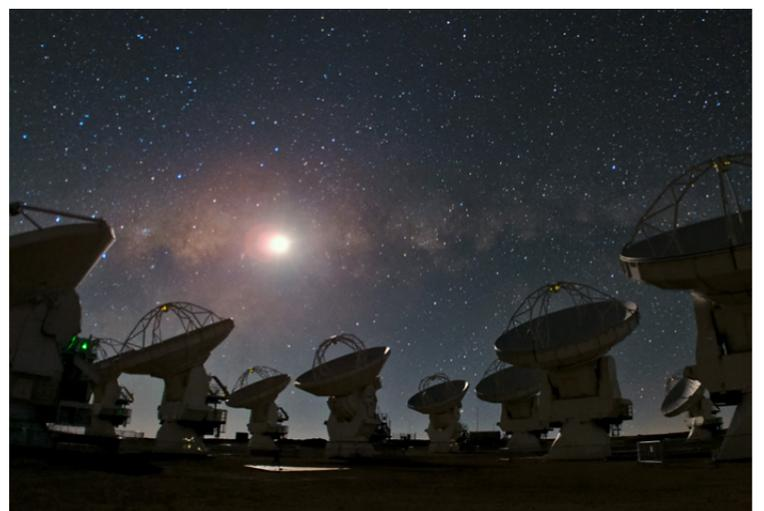
El Atacama Large Millimeter/submillimeter Array —ALMA— es un interferómetro compuesto por 66 antenas que pueden observar longitudes de onda milimétricas. Es uno de los mayores proyectos astronómicos del mundo y lo lideran instituciones como el Observatorio Europeo Austral —ESO—, la Fundación Nacional de Ciencia de Estados Unidos —NSF— y la República de Chile.
