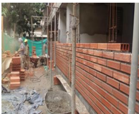
Fotografía N°10 Construcción de Mampostería
