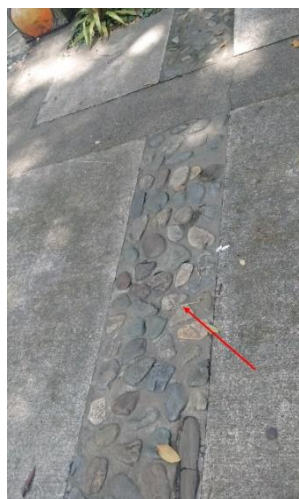
Fotografía N° 3 Faja en piedra
